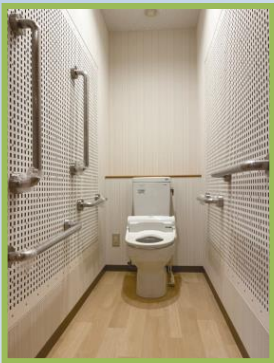
〈トイレ〉 ●可動式手すり●
